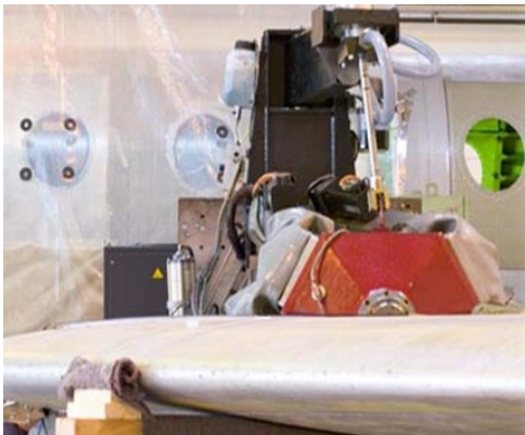
HEXAPODE usinage sur site Réparation sans déplacer la pièce
